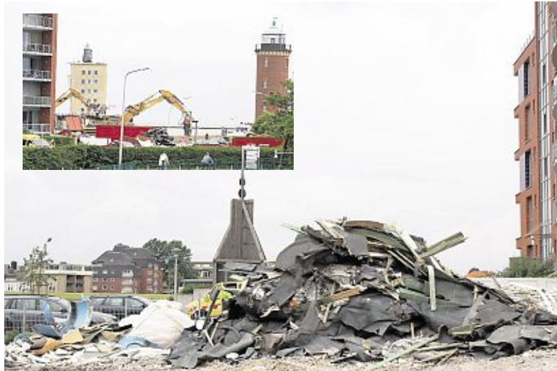
Und am Ende bleiben nur ein paar Haufen Beton, Schutt und Dachpappe: Ungeachtet vom touristischen Betrieb verordneten die beiden Bagger ihr Werk. Fotos: Reese-Winne
